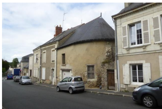
Ancienne chapelle, rue Saint Nicolas, Baugé
