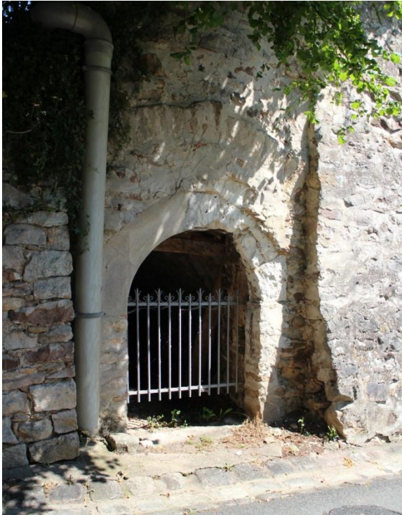
Entrée de cave, rue du Pont Godeau, Le Vieil Baugé
