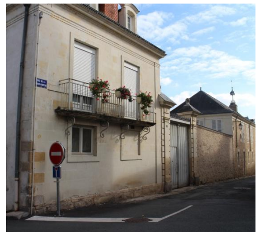
Balcon /ferronnerie, rue Pasteur, Baugé
