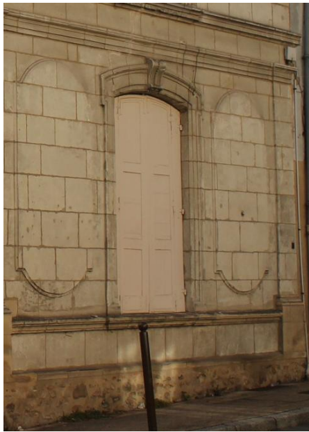
Encadrement de baie en saillie
