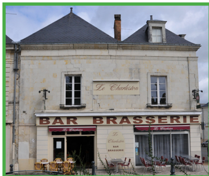
Les stores s'intègrent dans la largeur des baies permettant une insertion relativement discrète dans la façade.
