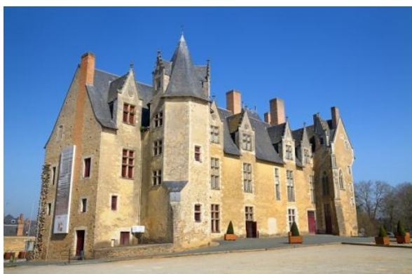
Château de Baugé
