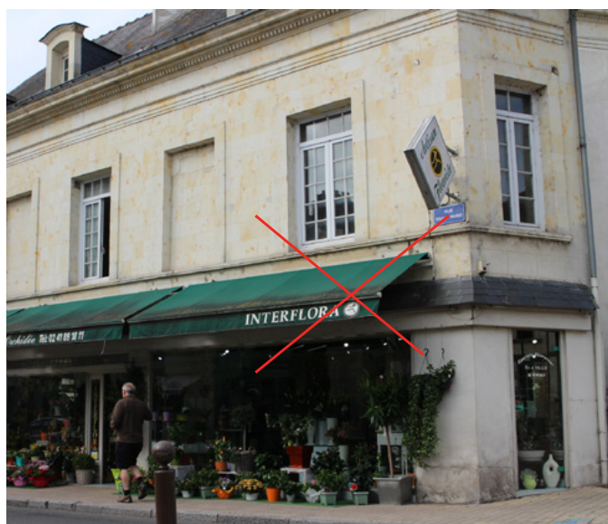
Le store est implanté trop haut, il cache le petit auvent en ardoise existant qui file le long de la façade.
