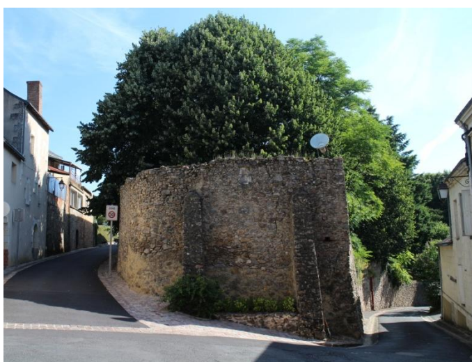
Rue du Pont Godeau, Le Vieil Baugé
