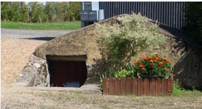
Entrée de cave, Le Vieil Baugé
