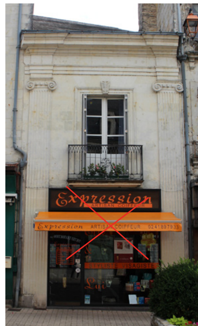
La teinte trop «criarde» dénote avec la façade tuffeau.
