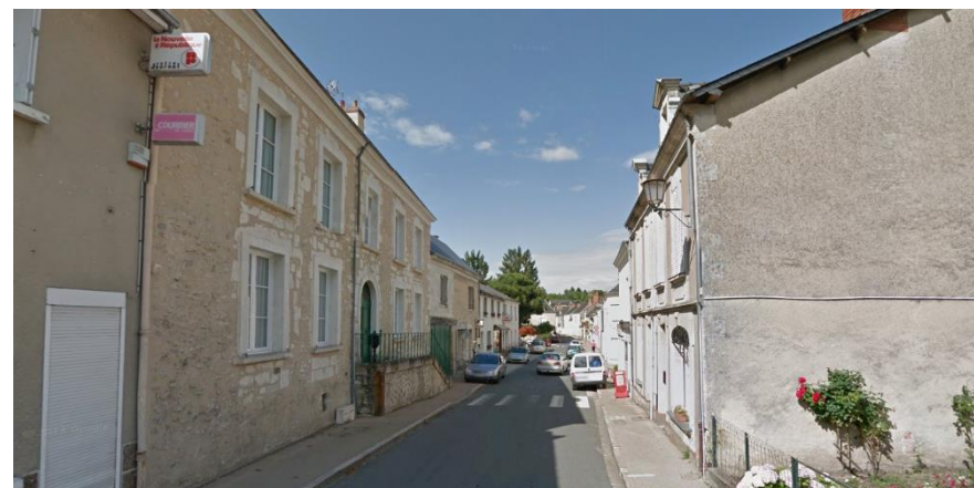
Exemple d'entrée de ville à l'architecture qualitative (r. des Moulins, Mouliherne) – source : StreetView
