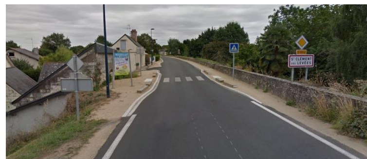
Mise en place de trottoirs à l'entrée de ville de Saint-Clément-des-Levées
