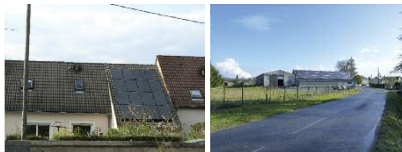
Exemples de panneaux solaires couvrant la quasi-totalité d'un pan de toiture de garage (à gauche) et d'un versant de la toiture d'un hangar agricole (à droite) – Source : Plan de gestion du Val de Loire - UNESCO
