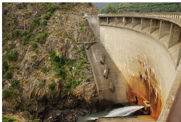
Barrage de Villefort
