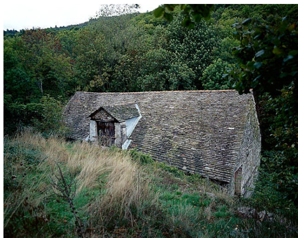
Fonderie des Mines de Villefort
