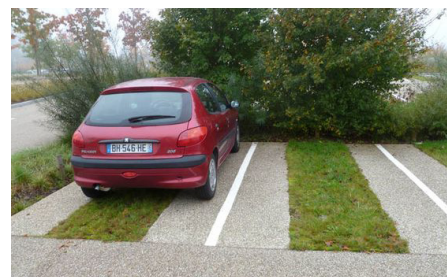
Traitement de sol perméable
