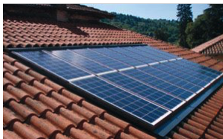
Implantations autorisée : intégrée à la toiture
