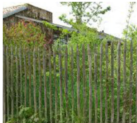
Clôture en bois
