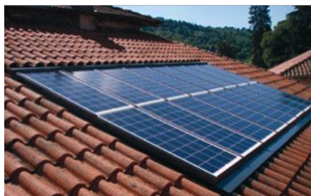
Implantations autorisée : intégrée à la toiture
