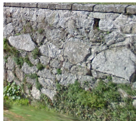
Clôture maçonnée créant soutènement
