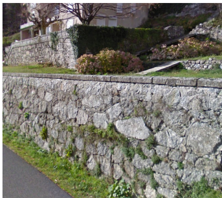
Mur de clôture créant soutènement
