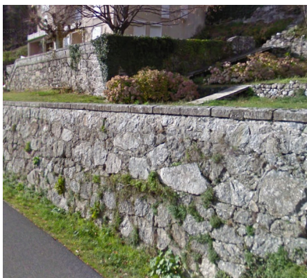
Mur de clôture créant soutènement
