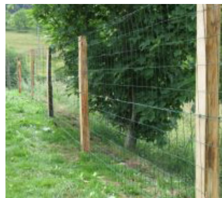
Clôture grillage souple et pieux de bois
