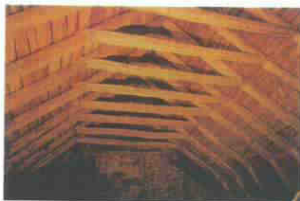
Une charpente soutenant la lauze
