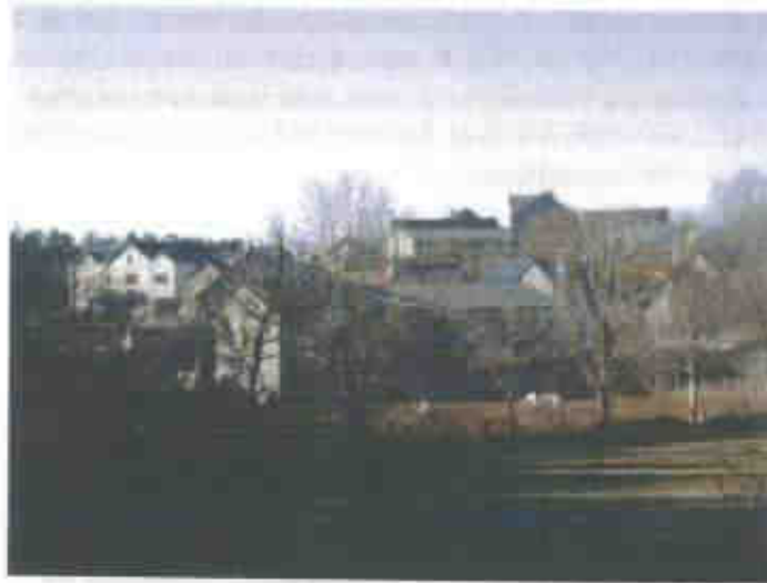
Vue du village par la RD67
