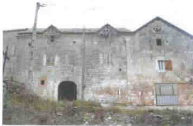
La construction de futurs gîtes à Longviala
