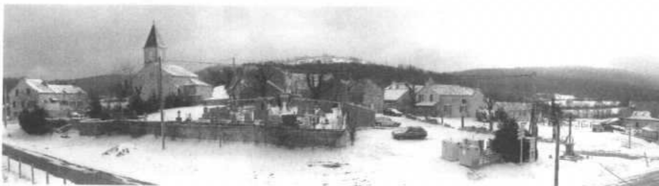
Panorama du village enneigé de La Tieule
