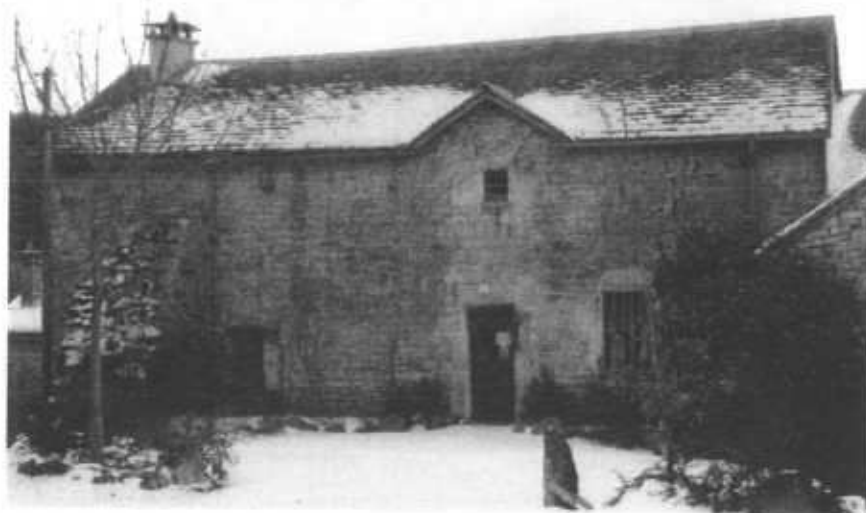
Lucarnes et cheminées de l'auberge de La Tieule
