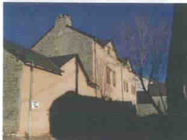
3 logements communaux dans l'ancien presbytère
