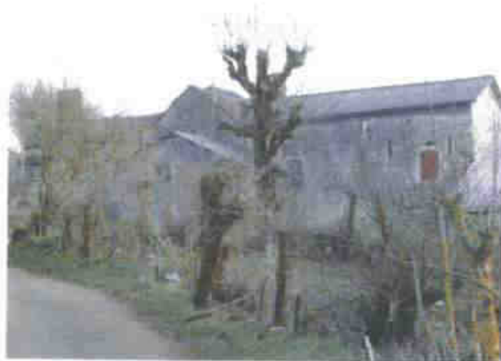
Bâti au Duc
