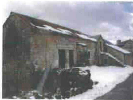
Réhabilitation en cours à Longviala (gîte rural)
