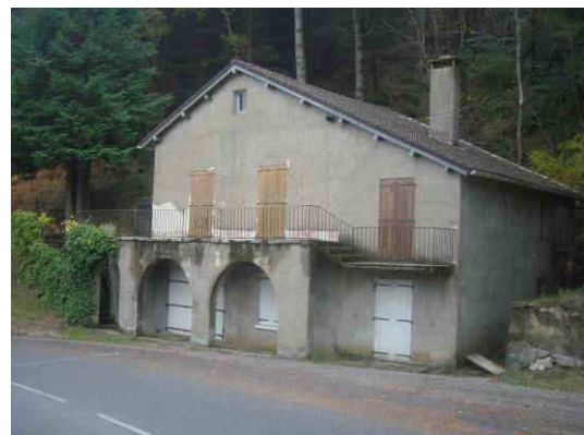
Une construction typique de l'après-guerre, au col de Jalcreste
