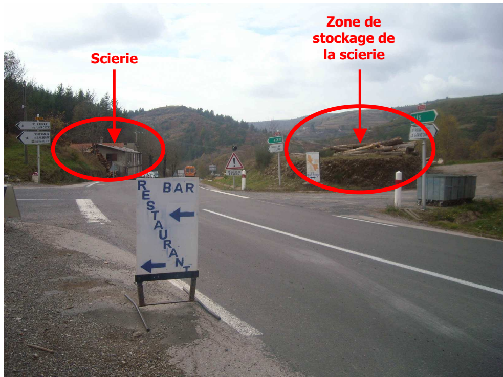
Le Col de Jalcreste : la zone de stockage de la scierie actuelle
