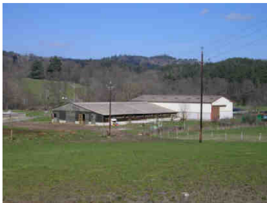
Le bâtiment d'élevage
