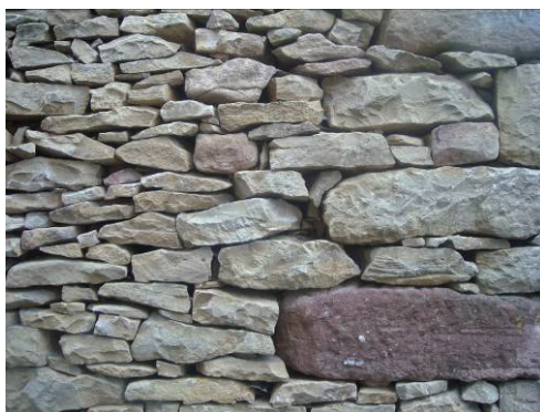
Appareillage de calcaire
