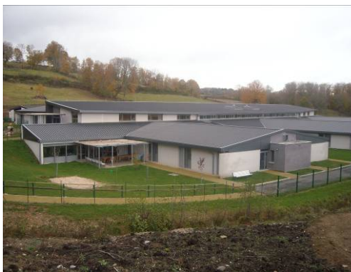
La M.A.S. « Aubrac » dans des locaux flambants neufs à l'extrême nord de l'agglomération
