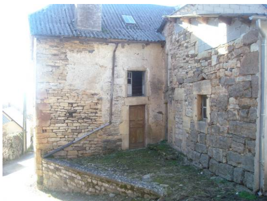
exemple de rénovation à mener
