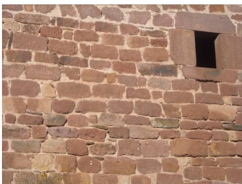
Appareillage de Grès rose, caractéristique des rougiers de la vallée du Lot. Sa taille plus commode se lit dans la géométrie des blocs et leur assemblage.
