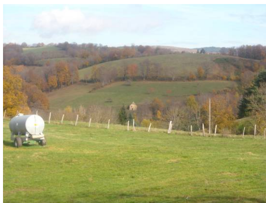
Exemple de bâtiment faisant l'objet d'un « pastillage »
