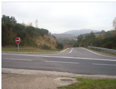
Le quart d'échangeur (sortie n°39.2) qui permet aux usagers en provenance du nord de rejoindre Saint-Germain-du-Teil
