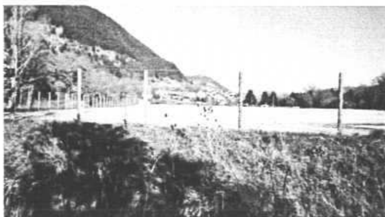
- Le bassin de lagunage de Saint-Bauzile -
