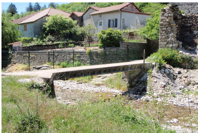
La passerelle à Saint-André-Capcèze
