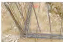
Nœud de chaînage - Continuité mécanique
