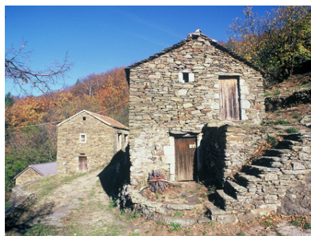
Habitations implantées parallèlement à la pente △
