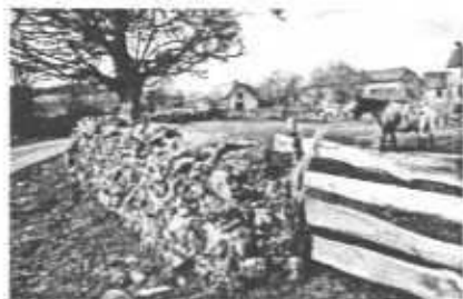
Mur de clôture calcaire à Monteils
