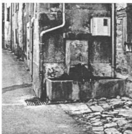
Bac en ciment inesthétique. L'ensemble fontaine et pavage n'est pas inintéressant. Située sur la voie romaine au Monastier.
