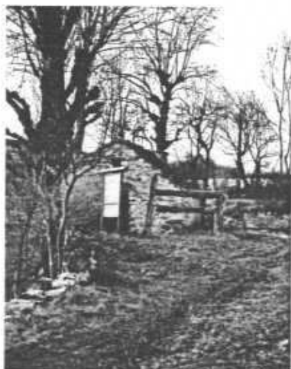
Four à pain de Pin, situé en périphérie du village proche du ferradou et du puits du village. Ce four vient de faire l'objet d'une réfection.
