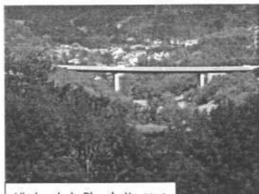
Viaduc de la Planchette sous lequel passe le ruisseau
