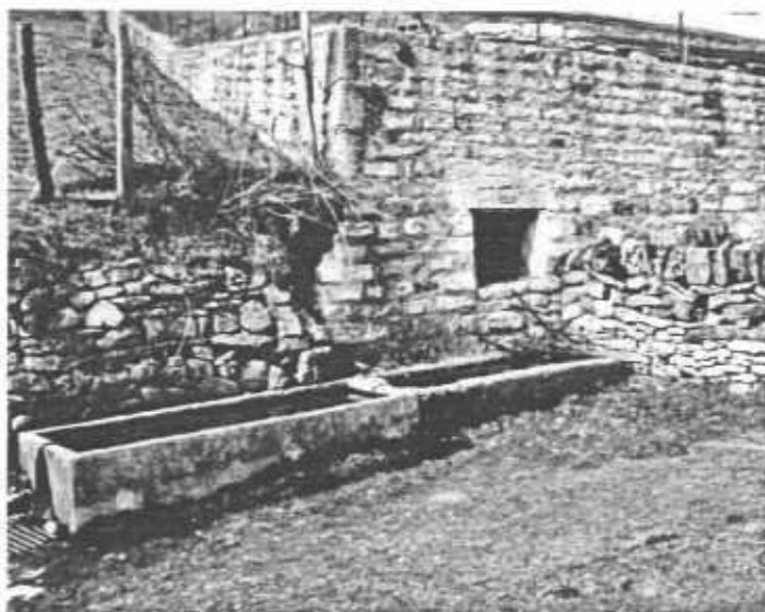
Fontaine composée d'un bac de granit et d'un bac en ciment. A la sortie du village du ségala sur la route de Monteils.
