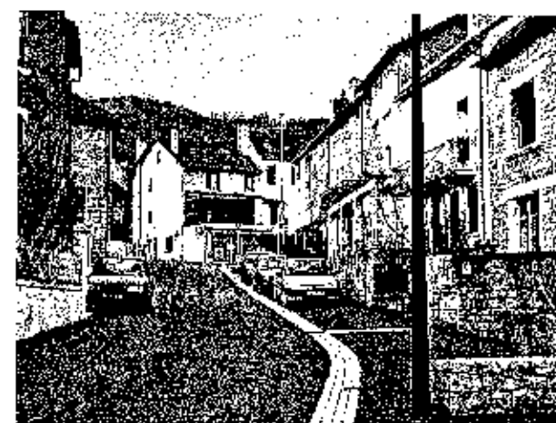
PARKING VOIE ROMAINE
