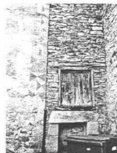
N°22 - linteau plat Chaînage coloré
