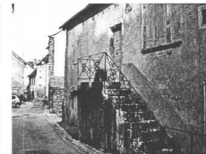
N°24 - Garde corps ferronné
