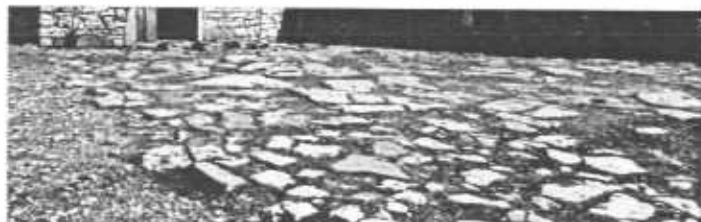
Dallage calcaire corps de ferme du Crespin. Dalles de grandes tailles et espacées.
