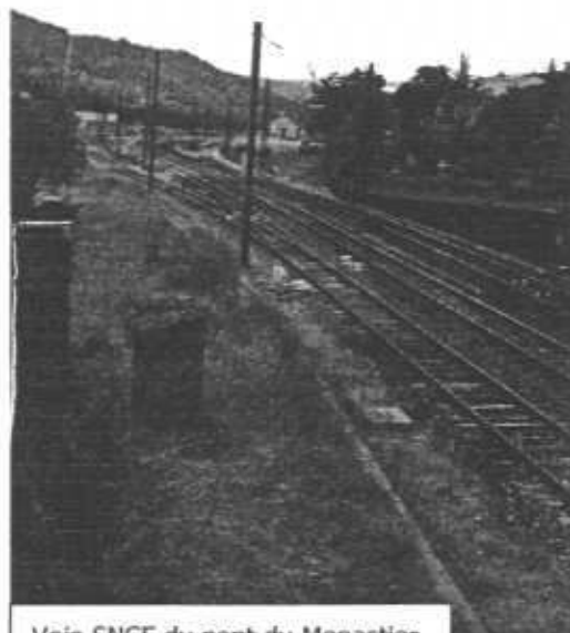
Voie SNCF du pont du Monastier
