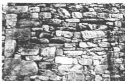
Façade en gneiss et calcaire à Moriès. Pierres d'angles calcaires.
