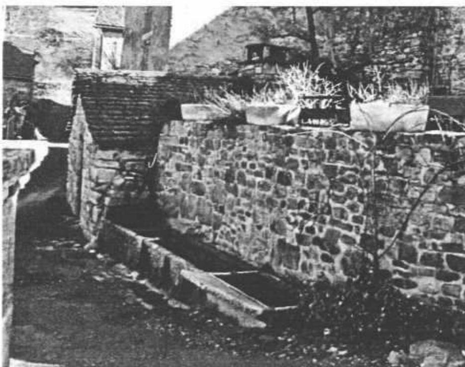
Fontaine adossée au four à pain communal, composée de deux blocs de granit monolithiques et d'un bac de ciment. Cet ensemble situé sur la place de l'Eglise de Moriès est intéressant mis à part le bloc béton.
