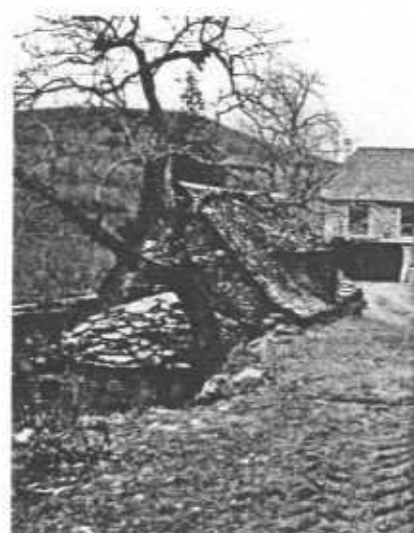
Four à pain de La Felgère, il est situé en prolongement d'une remise sur une propriété privée. Son état est moyen.
