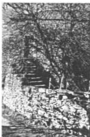
Mur et escaliers calcaires au Crespin
