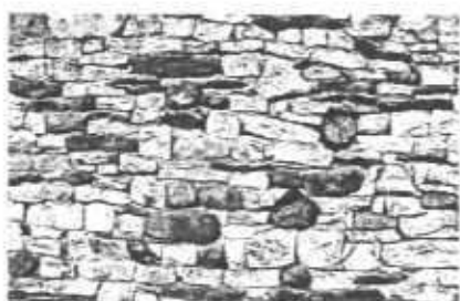
Façade en schistes et calcaire au Ségala
