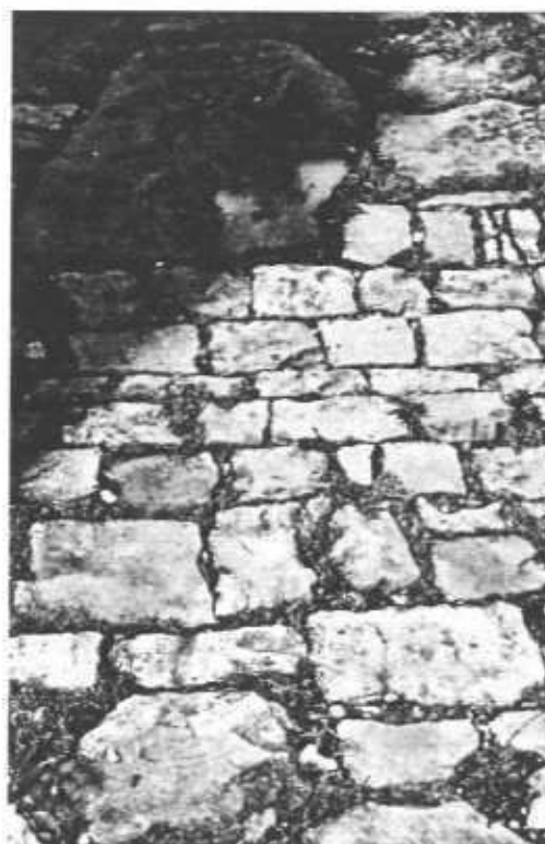
Dallage calcaire dans la rue au Bruel, joints de terre étroits.
