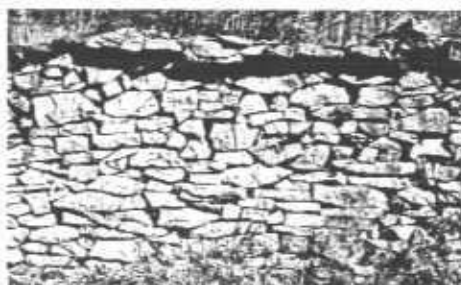
Clôture calcaire au dessus du Crespin. Couronnement en pierres plates
