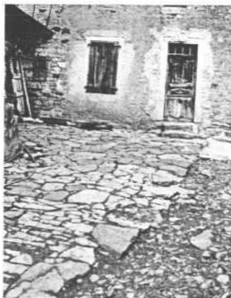
Dallage de La Borie du Bœuf. Dalles de grandes tailles resserrées et formant une sorte de tapis calcaire.
