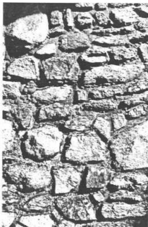
Dallage devant maison d'habitation à Moriès. Petites pierres plates rejointées au ciment.
