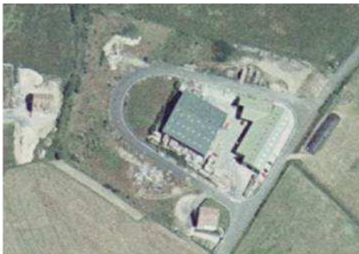
Photo aérienne de la zone artisanale
