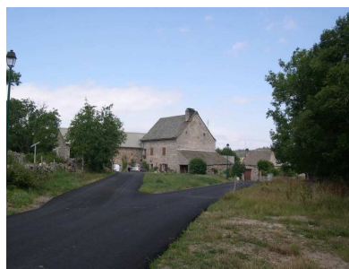
Aubars : un bâti ancien
