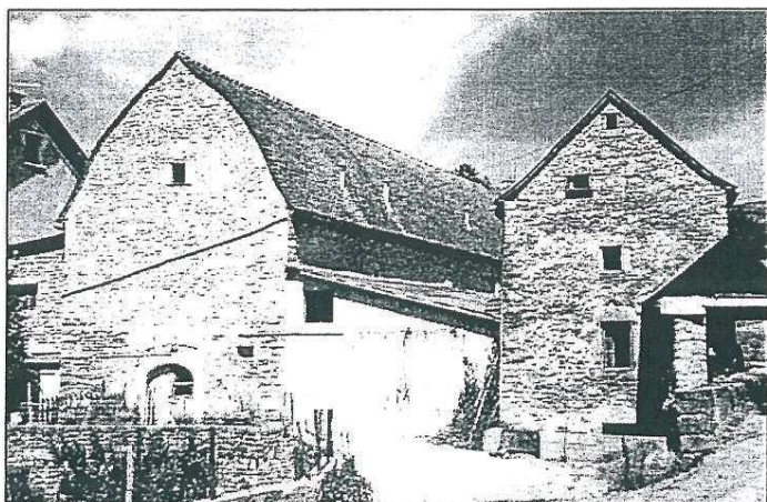
Photo n°7: Le Bruel qui garde encore les traces de l'héritage agricole, vestige d'un ensemble architectural remarquable
