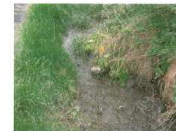
Rejet dans le fossé communal
