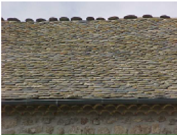
Toiture en lauze
