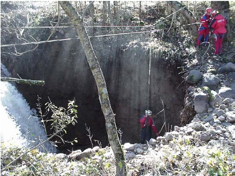
Figure 12: Effondrement sur le lit du Bramont apparu en novembre 2003 (photo DDT 48).
