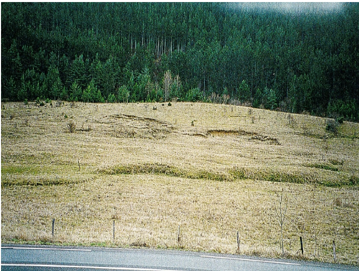
Figure 10: Niches d'arrachement à l'amont de la RN88, au Sud de la Boissonnade
