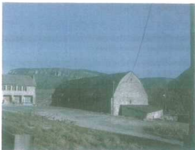
Grange massive à RECOULETTES avec charpente en carène de bateau renversée appelée aussi "Philibert Delorme" et couverte de lauzes de schiste
