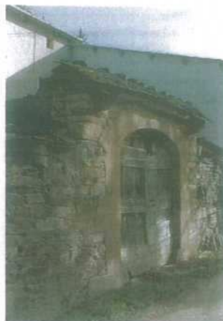
Porte charretière sous chaperon donnant accès à une cour fermée à PIERREFICHE
