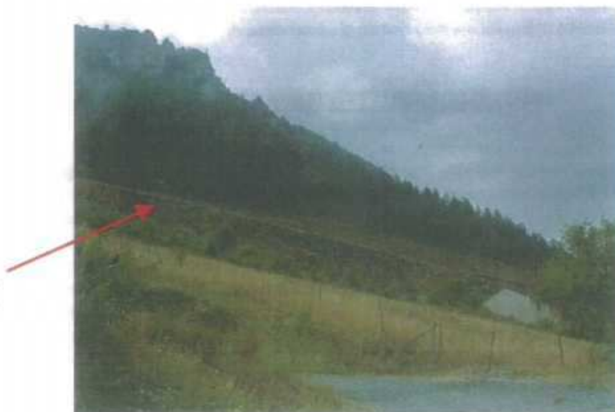
Merlon de protection des habitations contre les chutes de blocs.
