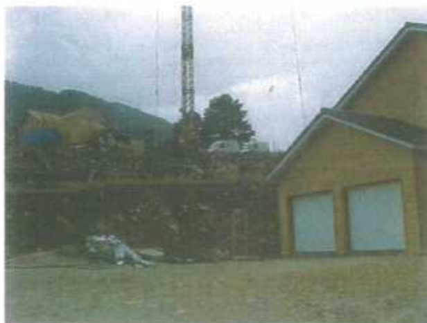
Les premières maisons en construction du lotissement à RECOULETTES
