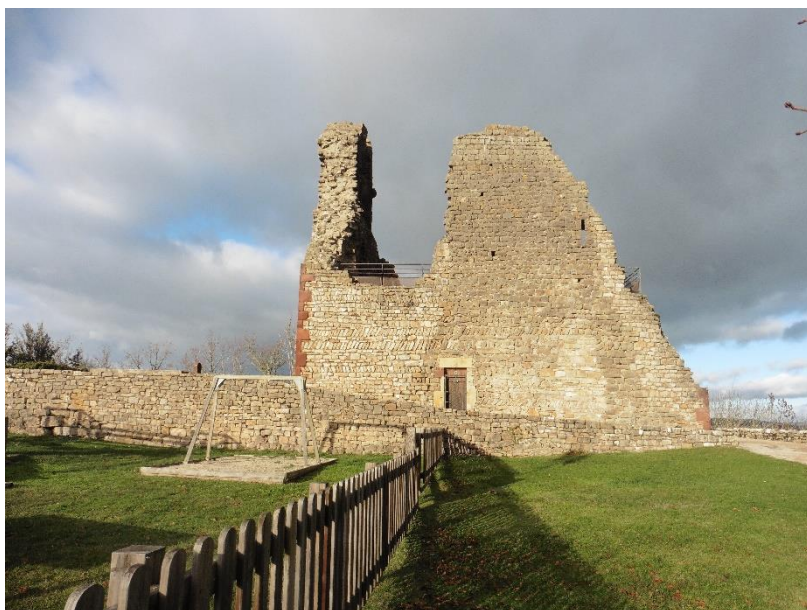
Le château/donjon de Canilhac à fait l'objet de restauration et d'aménagements
