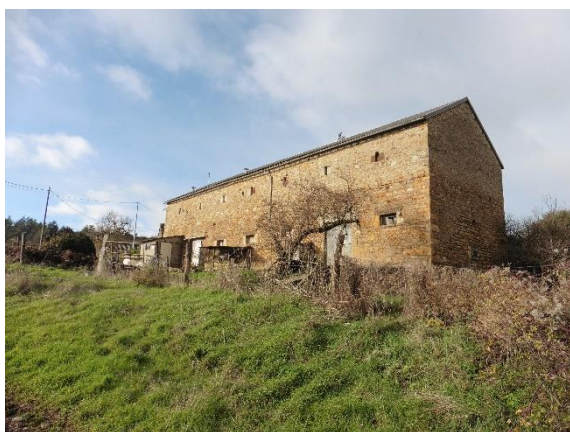
Grange-étable traditionnelle caussenarde à Toutes Aures
