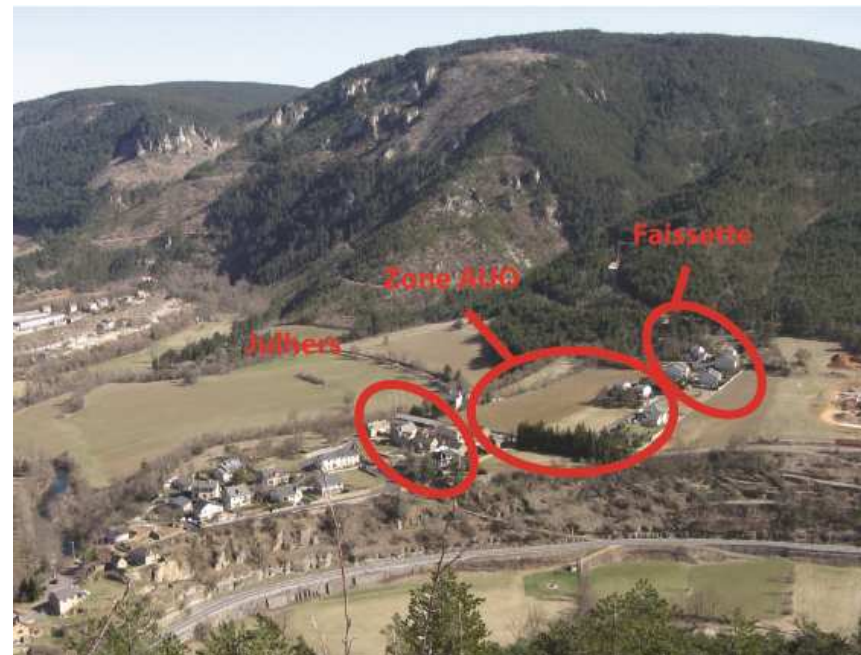
Localisation générale du secteur dans le bourg de Balsièges. Vue depuis le site du Lion de Balsièges.
