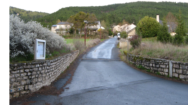
La voie communale de desserte de la Faissette
