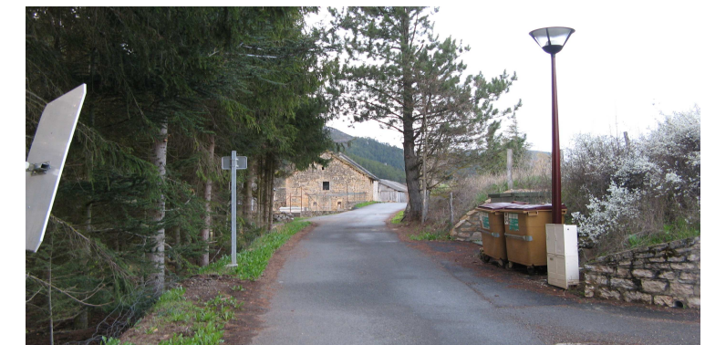
La voie communale VC10 située en aval du secteur.
