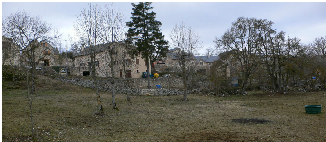
Vu du centre de Changefège
