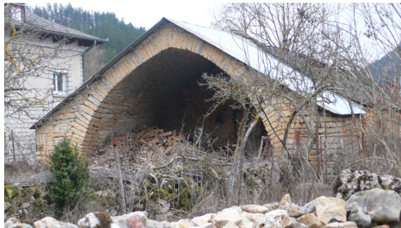
Hangar voûté en berceau brisé ouvert sur l'aire à battre à Bramonas
