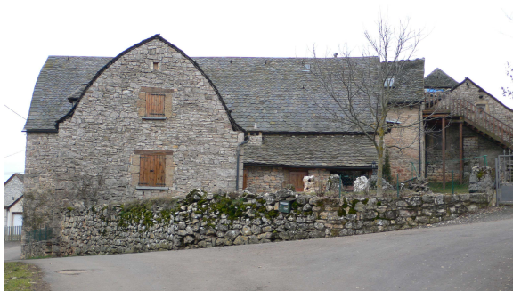
Toiture à la Philibert sur Changefège
