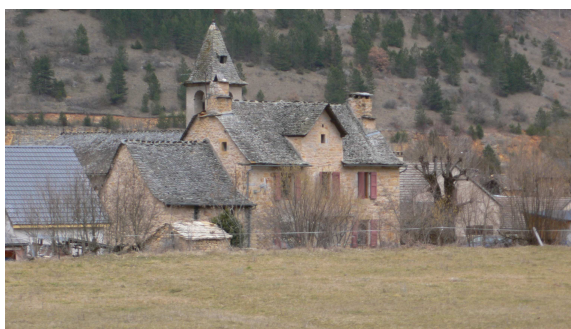
Bramonas : Maison d'habitation avec corbeaux sous toiture
