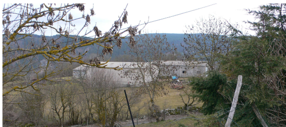
Bâtiment agricole à l'entrée de Changefège
