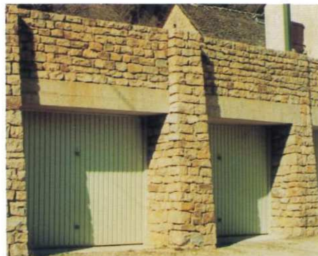
Rouffiac (Bessin architecte)
