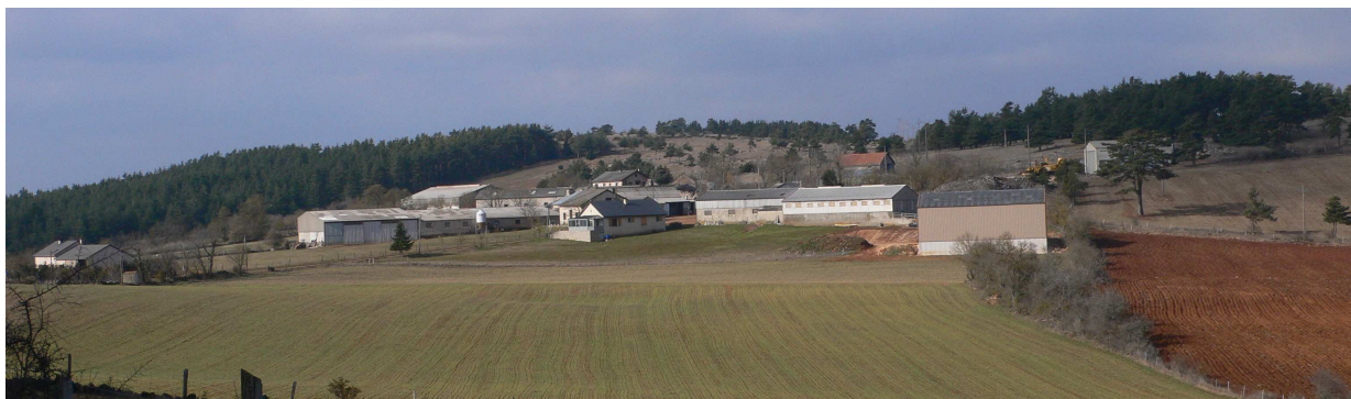
Plusieurs bâtiments agricoles à l'entrée de l'Archette
