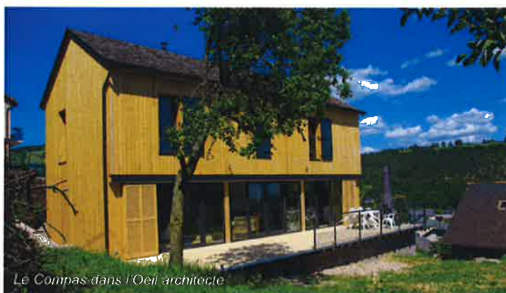
Maison individuelle, Le Compas dans l'Oeil architecte
