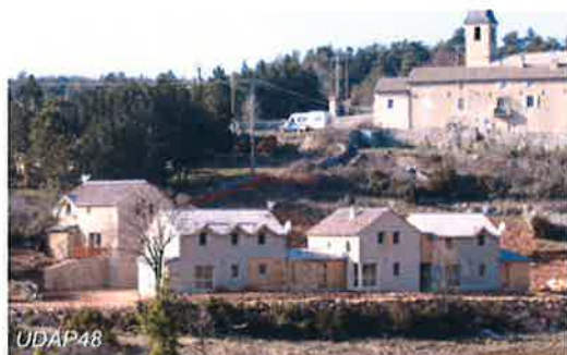
Logements locatifs, Atelier Bessin et Sebelin architectes
