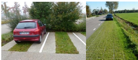
Bandes enherbées et stationnement avec système alvéolaire
