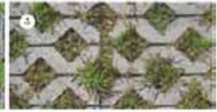
4 Dalle gazon béton
