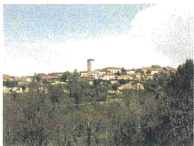
Façade patrimoniale de la bastide ; UrbaDoc 2016
