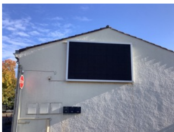
Publicité / préenseigne apposée sur mur et dépassant des limites de l'égout du toit, Marmande, Novembre 2023.
