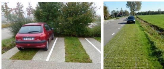
Bandes enherbées et stationnement avec système alvéolaire
