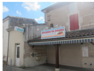
Alignement effectué par le préau, rue Principale, © UrbaDoc 2014
