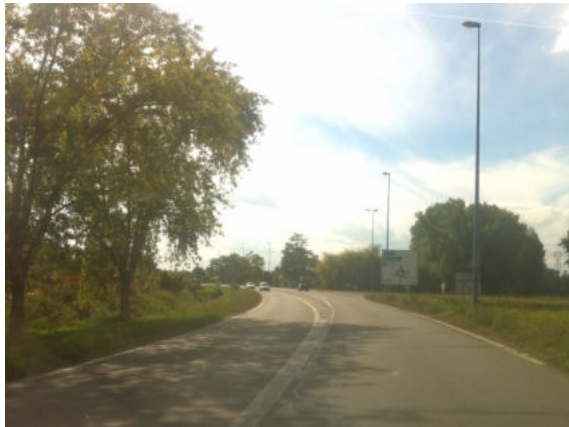
Prégnance de la RD 666 délimitant le bourg sur sa frange Nord, © UrbaDoc Septembre 2014
