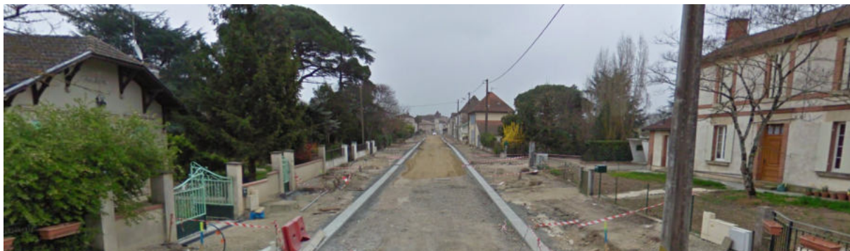
Travaux d'amélioration de la traverse du bourg, © Google Maps, 2013
