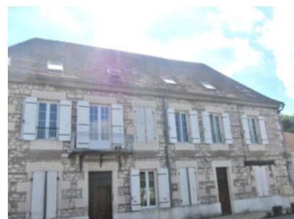
Ouverture de toit de type lucarne, © UrbaDoc, 2014
