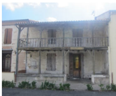
Utilisation du bois pour la constitution d'un balcon ou mirande, © UrbaDoc, 2014
