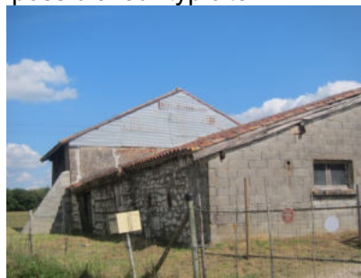
Utilisation de matériaux peu encline au maintien des caractéristiques vernaculaires du bâti, © UrbaDoc Septembre 2014
