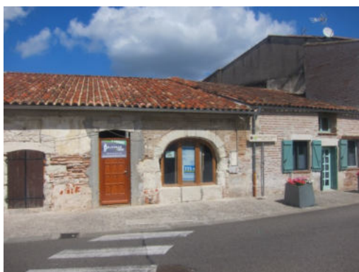
Bâti traditionnel, ancienne remise agricole de plain-pied © Urbadoc, 2014
