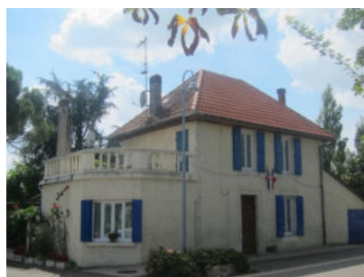
Toiture à 4 pans, © UrbaDoc 2014
