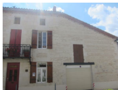
Toiture à pan cassé, © UrbaDoc 2014
