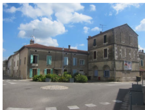
Ancienne mairie-halle en R+2, © UrbaDoc 2014
