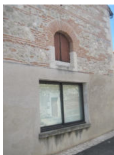
Ouverture créée ou réhabilitée sous forme de baie vitrée, © UrbaDoc, 2014
