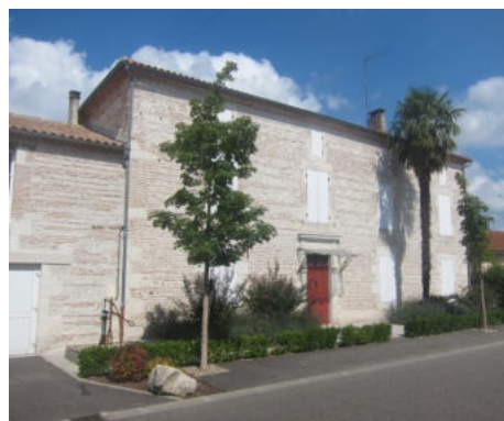
Matériaux de construction traditionnels : assemblage de mortier et de brique, © UrbaDoc, 2014
