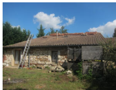
Bâti traditionnel en cours de réhabilitation, © UrbaDoc 2014
