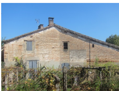
Les références aux caractéristiques agrestes sont perceptibles y compris pour une partie du bâti présent dans le centre bourg : matériaux de construction traditionnel, large ouverture facilitant le stockage du matériel agricole, petits oculi dans les combles permettant de ventiler les productions agricoles stockées dans les greniers.
