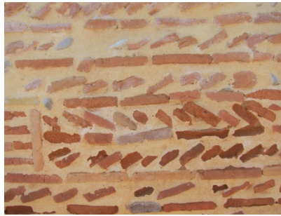
Briques apparentes disposées en épi, © UrbaDoc 2014
