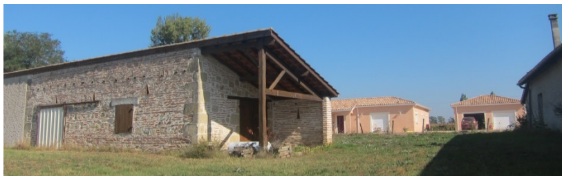
Confrontation bâti traditionnel, et constructions pavillonnaires à Sarlande/Villotte, © UrbaDoc, 2014
