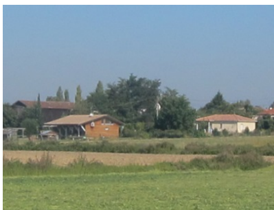
Construction avec bardage bois à Sabey-Sabut, © UrbaDoc, 2014
