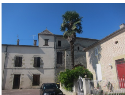
Les références aux caractéristiques agrestes sont perceptibles y compris pour une partie du bâti présent dans le centre bourg : matériaux de construction traditionnel, large ouverture facilitant le stockage du matériel agricole, petits oculi dans les combles permettant de ventiler les productions agricoles stockées dans les greniers.
