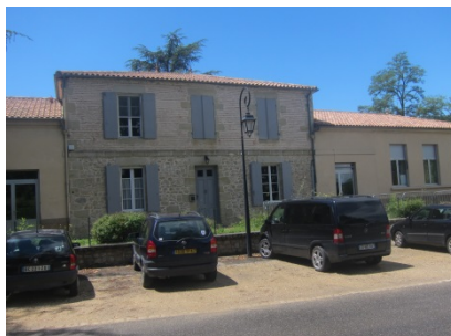
Toiture à 2 et 4 pans avec épi de faitage, groupe scolaire, © UrbaDoc 2014
