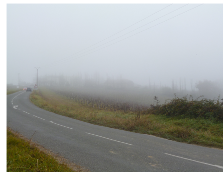
Entrée Nord, RD n°264, UrbaDoc 2017
