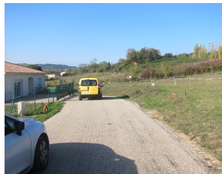
Amorce de voirie créée en appui de la route du Pech au Sud Est de la zone, © UrbaDoc, 2016.
