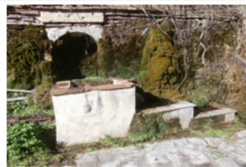
41 - Lavoir de la centrale électrique - chemin du moulin - AB 467
