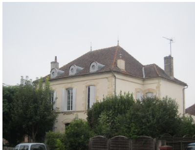
Toiture à 4 pans et lucarne en type œil de bœuf
