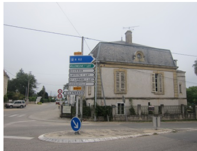
Toiture mansardée avec l'utilisation d'ardoise
