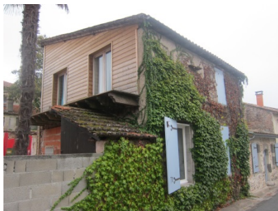
Matériau de construction traditionnel, et bois réutilisé comme matériaux contemporain sous forme de bardage bois et non plus sous forme de poutre apparente
