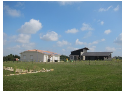
Maison d'architecte : toiture à un pan
