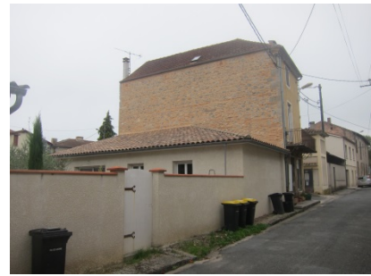
Renouvellement urbain : maison de plain-pied adossé à une bâtisse en R+2
