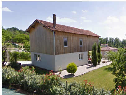
Réhabilitation séchoir, marge RD 271
