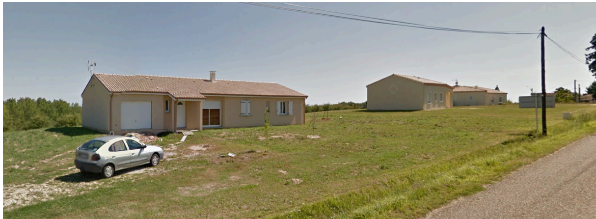
Constructions pavillonnaires situées à proximité, © Google Map's
