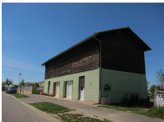
Changement de destination d'un séchoir en habitation, marge de la rue Marcel Prévost à l'entrée du lotissement les Jardins de Salomon
