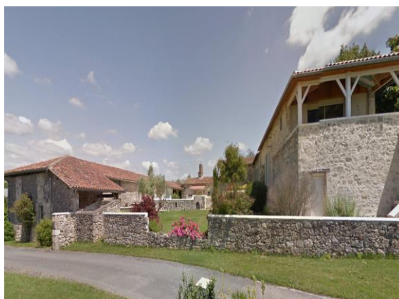
Réhabilitation du bâti agricole à Montazet
