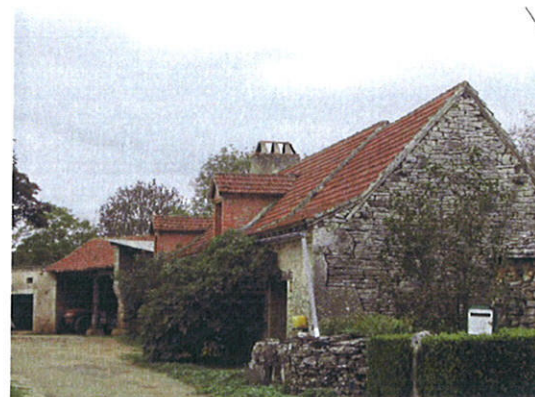
Constructions modestes (habitats et/ou dépendances) avec couvertures de tuiles plates, à 2 pans. L'insertion de lucarnes bâtie en toiture est fréquente. Ces lucarnes ponctuent et animent la grande masse que représente ces toitures forte pente.
