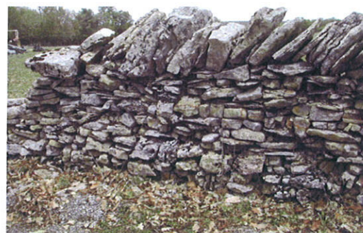
Murets de pierres sèches chapeautés de lauzes sur chant
