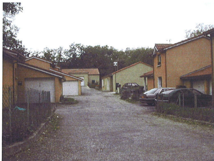
Lotissement ancien : alignement de garages en saillie, absence de paysagement et de hiérarchie dans le traitement de la voirie, manque de lisibilité entre public et privé .
