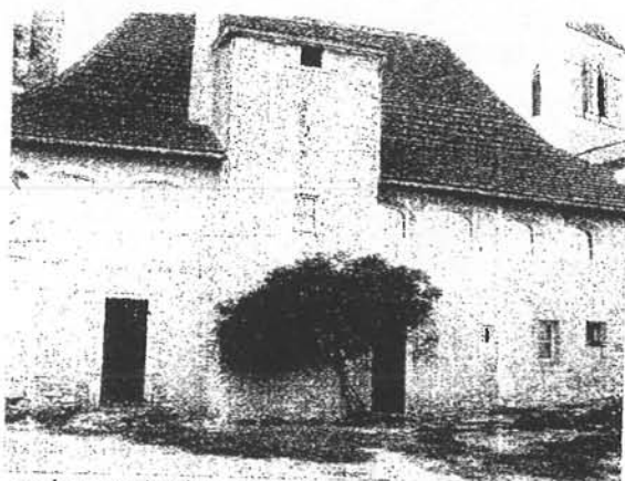
ancien presbytère situé dans le bourg de Berganty
