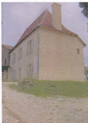
Réhabilitation du Presbytère
