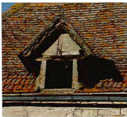
Petite lucarne maçonnée, Non passante
