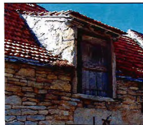
Petite lucarne Charpentée, passante
