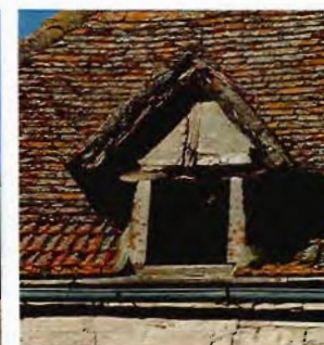
Petite lucarne Charpentée, passante
