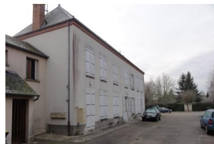
Bâtiment avec logements locatifs dans le centre bourg
