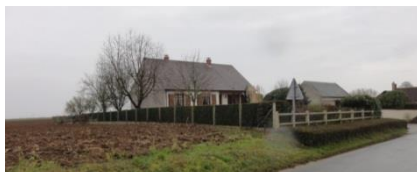
Extension récente avec « dent creuse » au premier plan
