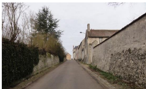
Imposants murs de clôture à l'alignement
