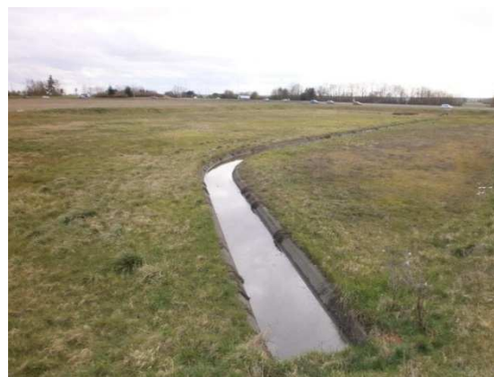
Bassin de rétention enherbé (avec étanchéité par argile compactée + caniveau béton)
