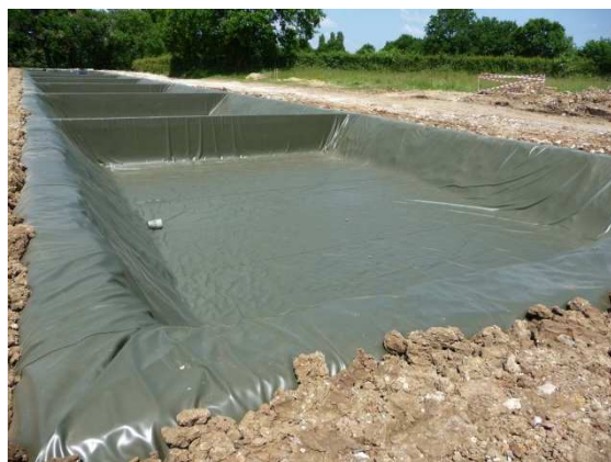
Bassin de rétention avec étanchéité par géomembrane
