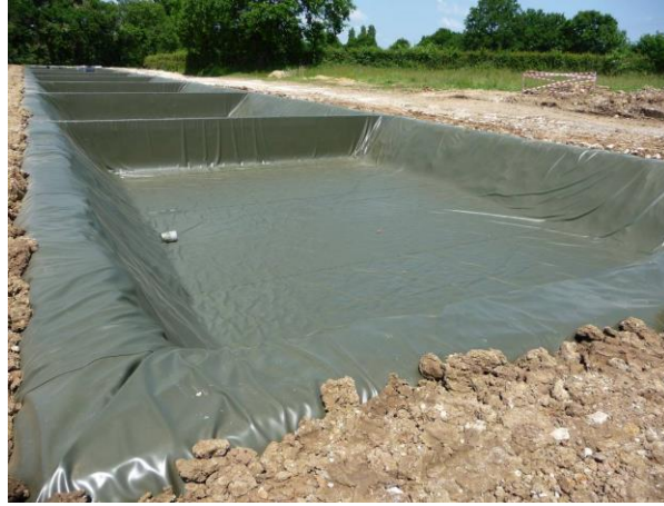
Bassin de rétention avec étanchéité par géomembrane
