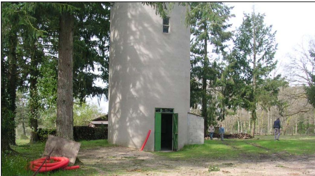
Photo 3 et photo 4: Captage AEP et pied du château d'eau
