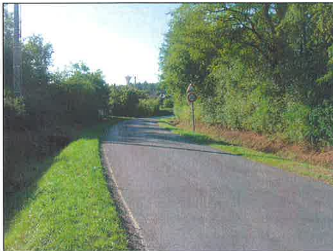
Photo 27 : Depuis la RD63 en provenance de Saint Aignan le Jaillard (vue n°2)
