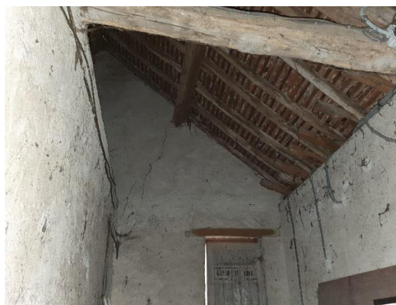
Photo 7 : Combles du bâtiment adjacent (IEA)
