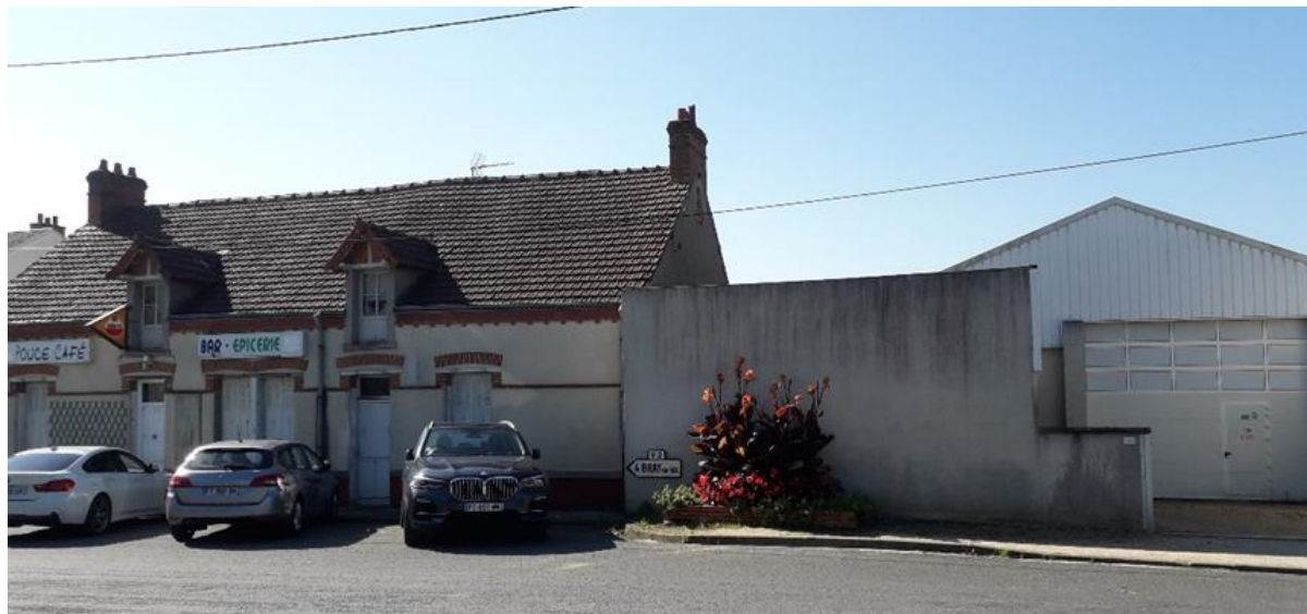
Figure 7 - Comparaison de la hauteur de l'usine (à droite) avec le bâtiment du café (au gauche)
