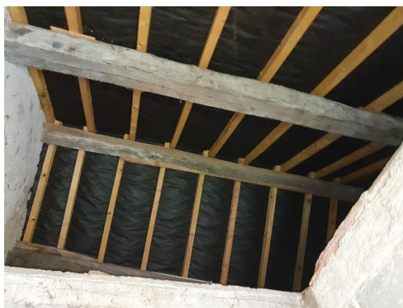
Photo 6 : Combles du bâtiment principal (IEA)
