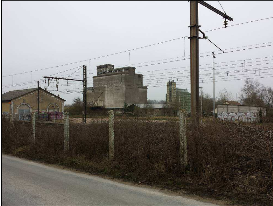
Au sud de la voie ferrée : anciens silos à démolir (en projet)
