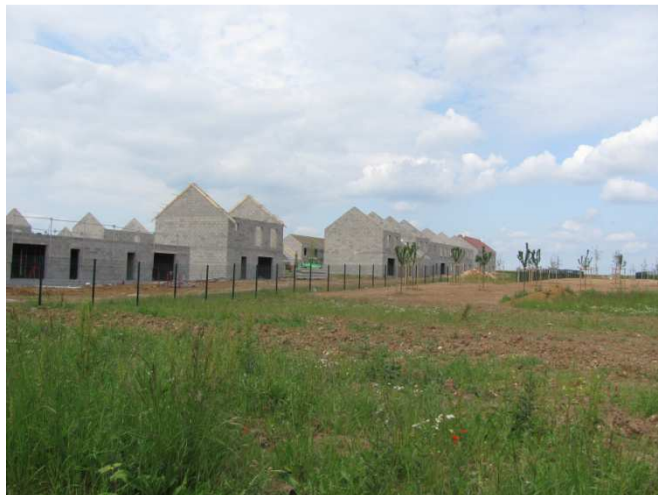
Chantier côté sud-est
