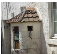
Puits, rue de la Margottière
