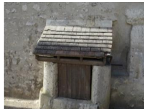
Puits, rue de la Margottière
