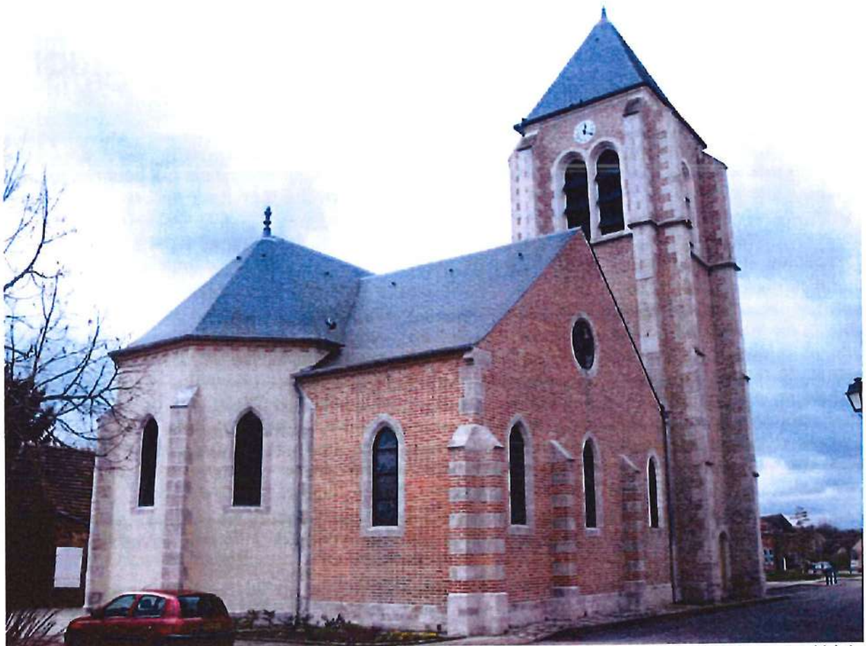
Le chevet polygonal, la sacristie et la chapelle de la Vierge, le clocher – cliché CRMH – DRAC Centre-Val de Loire
