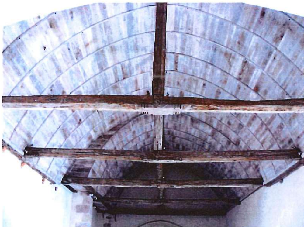
La charpente de la nef après dégagement et restauration - cliché CRMH – DRAC Centre-Val de Loire
