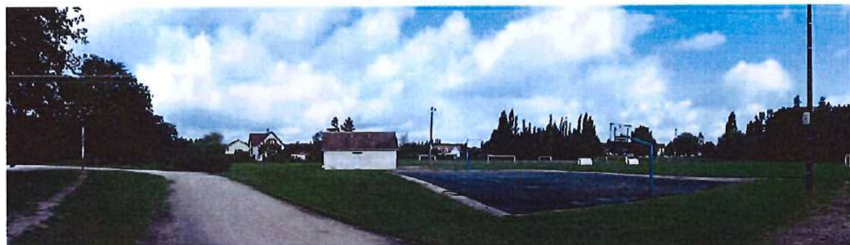
Photo 9 – Équipements sportifs communaux
