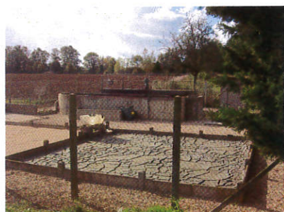
La station d'épuration
