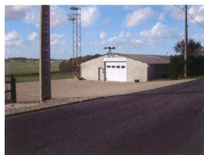
Caserne des pompiers
