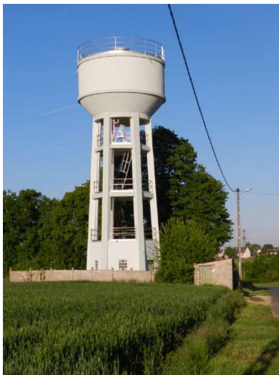
Photo 39 : Château d'eau (IEA)
