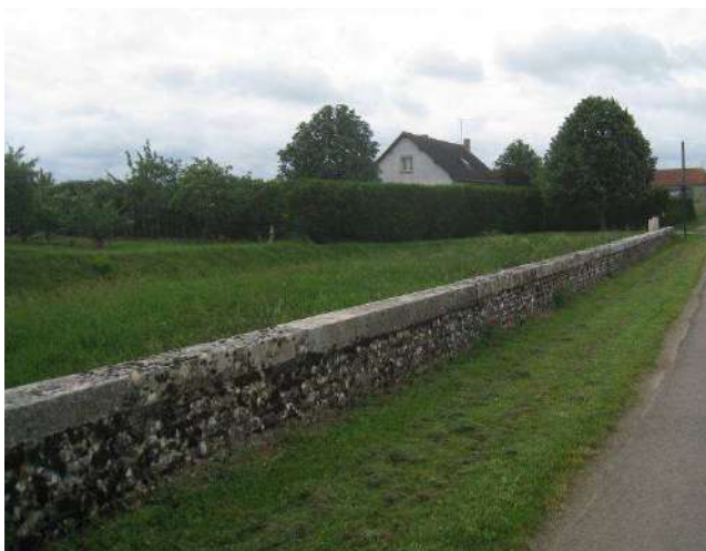
Photo 40 : Mare à l'entrée Nord d'Intvilliers (IEA)
