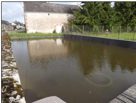
Réserve à incendie de Beaumont
